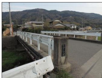
川島町の「下女の辻大橋」
