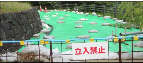
地滑りで山頂園路に亀裂
